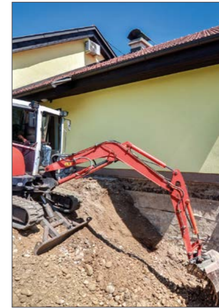
Die Erneuerung einer vertikalen Feuchteabdichtung im Kelleraußenmauerwerk gestaltet sich extrem aufwändig.
