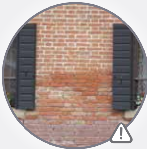
Feuchtes Mauerwerk
