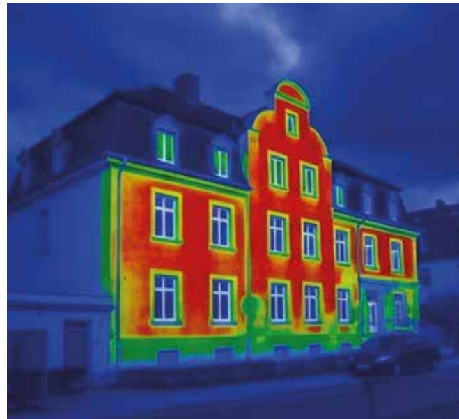
Abbildung 09: Aufnahme der Wandoberfläche mit einer Wärmebildkamera
