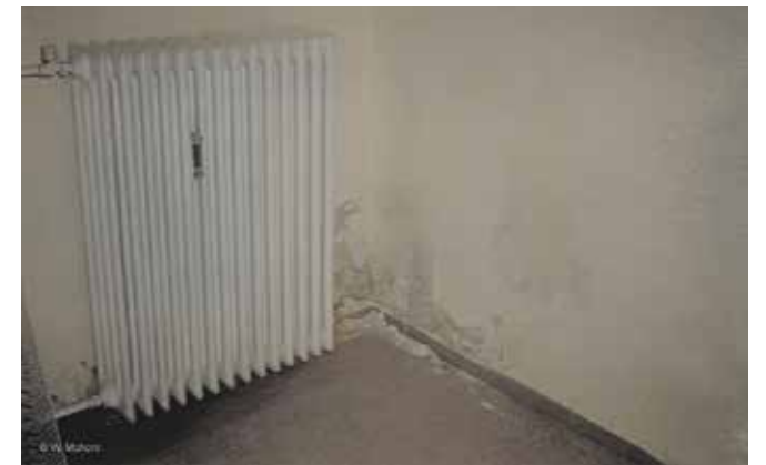
Abbildung 10+11: Vermehrte Salzausblühungen und Putzschäden sind aufgrund des „Dochteffektes“ in der Nähe des Heizkörpers sehr gut sichtbar.
