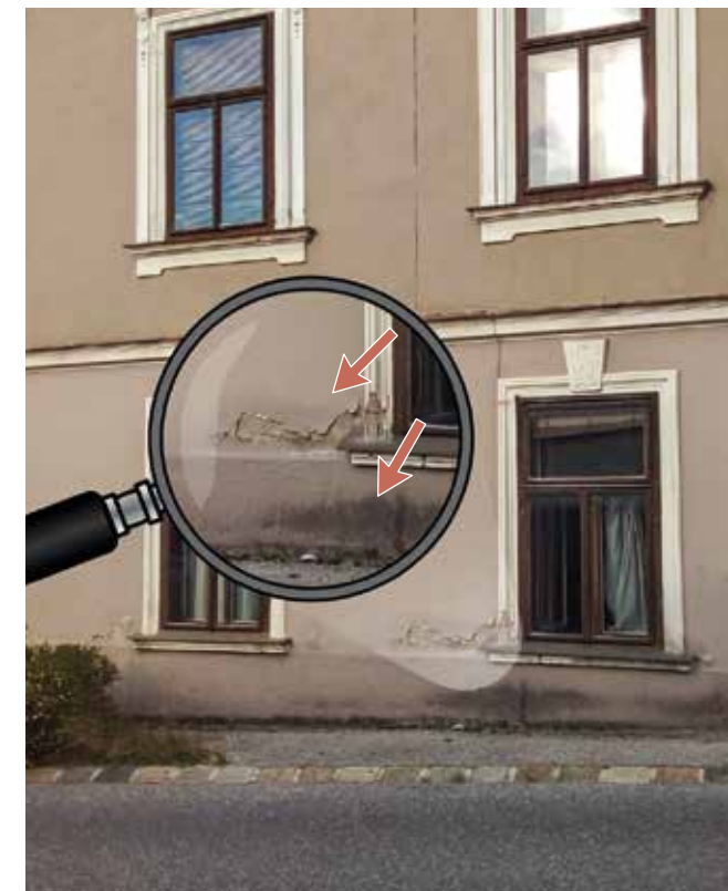
Abbildung 12: Auch an der Außenseite des Gebäudes ist dieses Phänomen durch stärkere Salzausblühungen und Putzschäden erkennbar
