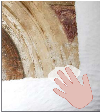
GRAFIK 06: Kompressen werden hier auf die von Salz beschädigten Fresken mit der Hand aufgetragen.
