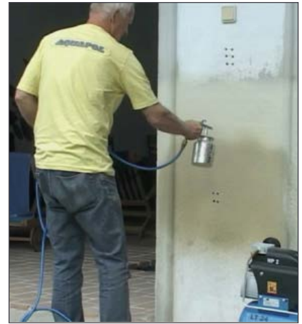
FOTO 03: Die maschinelle Entsorgung von Putzen bei großen Flächen.
