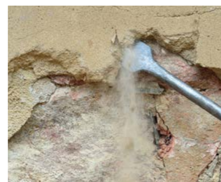
FOTO 03: Entfernung des Altputzes für vollständige Trockenlegung der Mauer
