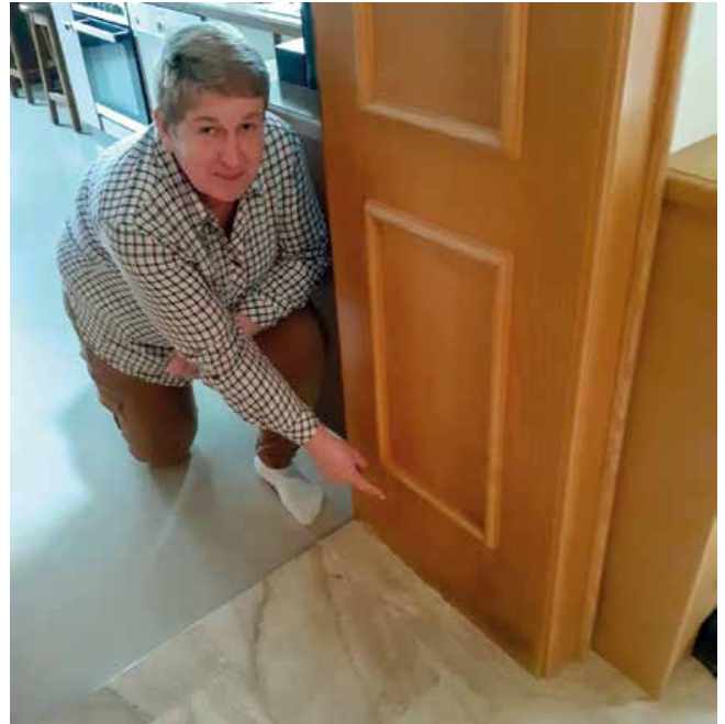
Frau Grenl zeigt auf die Höhe des Hochwassers von 2002 anhand des Türstockes, wo nur ein minimaler Schaden zurückblieb. Der Türstock musste nicht ausgetauscht werden.
