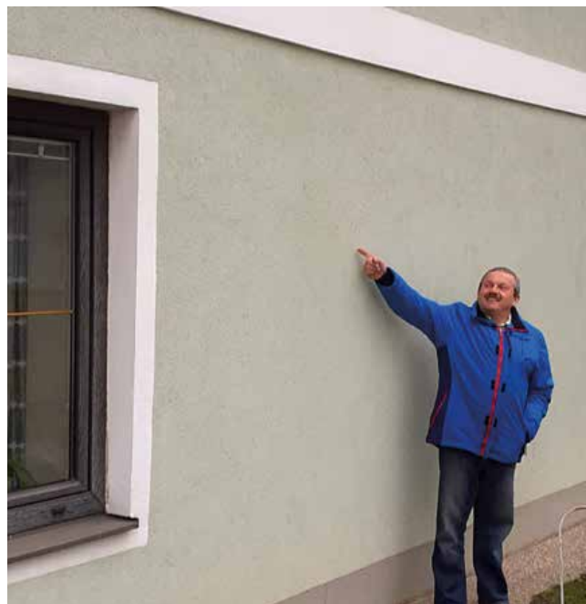
Herr Grenl zeigt die ehemalige Feuchteschadenshöhe an der Ostseite des Hauses an.
