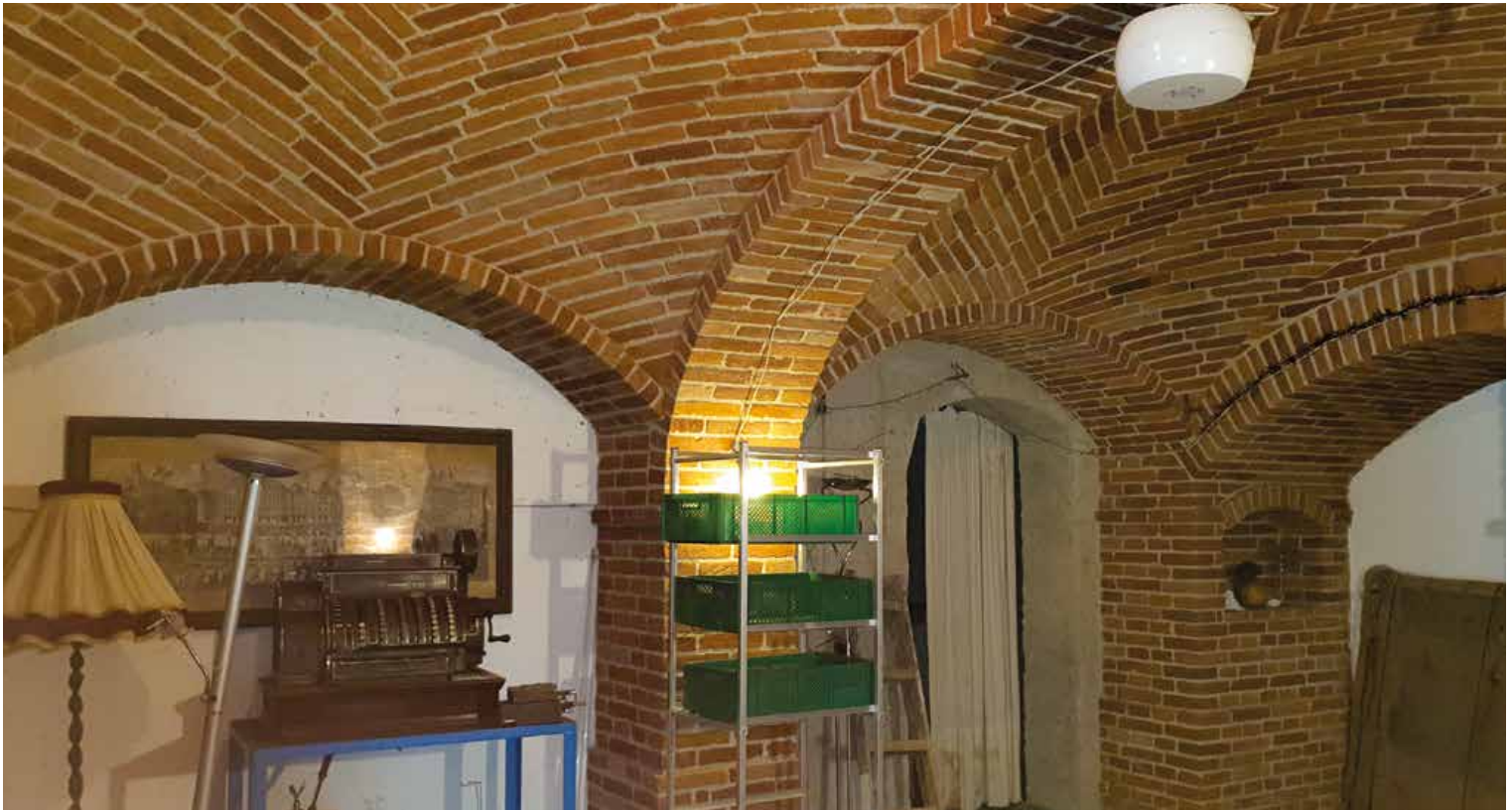
Der wunderschöne historisch anmutende Ziegel-Gewölbekeller mit seinen Pfeilern und dem unauffälligen AQUAPOL® System
