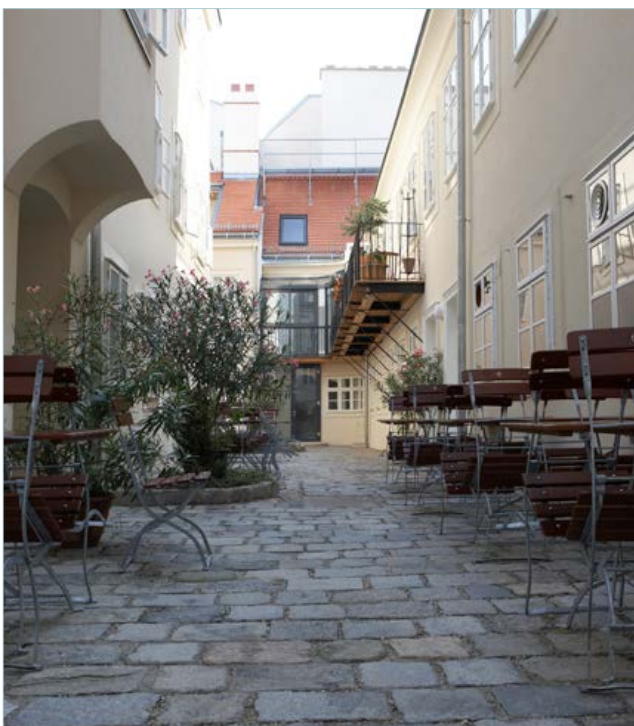
Das Gebäude nach der erfolgreichen Trockenlegung durch AQUAPOL und nach der Sanierung.
