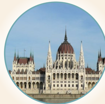
PARLAMENTSGEBÄUDE IN BUDAPEST (TEILBEREICH)
